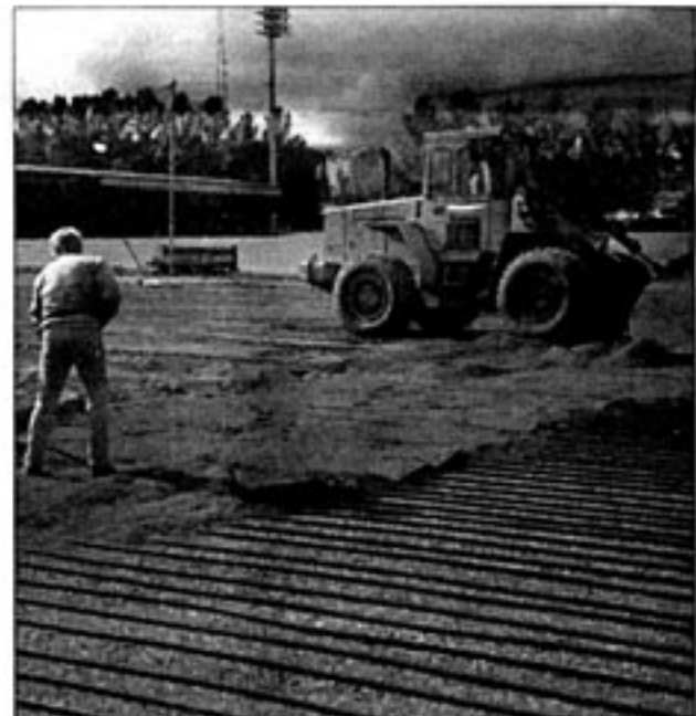
Sulatusputkiston asennustyö Lahdessa
